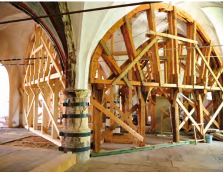
*Das durch Alter, Umbauten und Bodensetzungen geschädigte statische Gefüge der Alten Flügel von Schloss Sondershausen soll im SIP I dauerhaft gesichert werden. Seit Jahrzehnten geben Notsicherungen provisorischen Halt in der ehemaligen Bergbauregion.*
