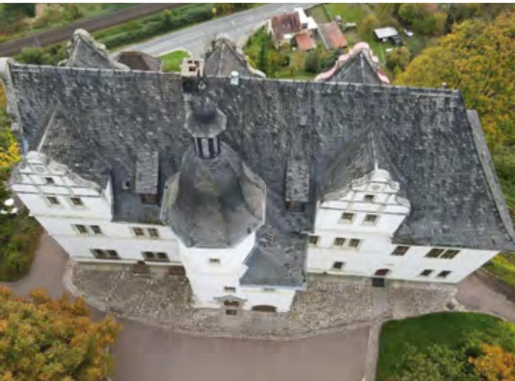
*Im Dach des Renaissanceschlusses auf den Dornburger Schlössern bröseln die Balken, konstruktive Verbindungen müssen wiederhergestellt werden. Dazu stehen im SIP I Maßnahmen an.*
