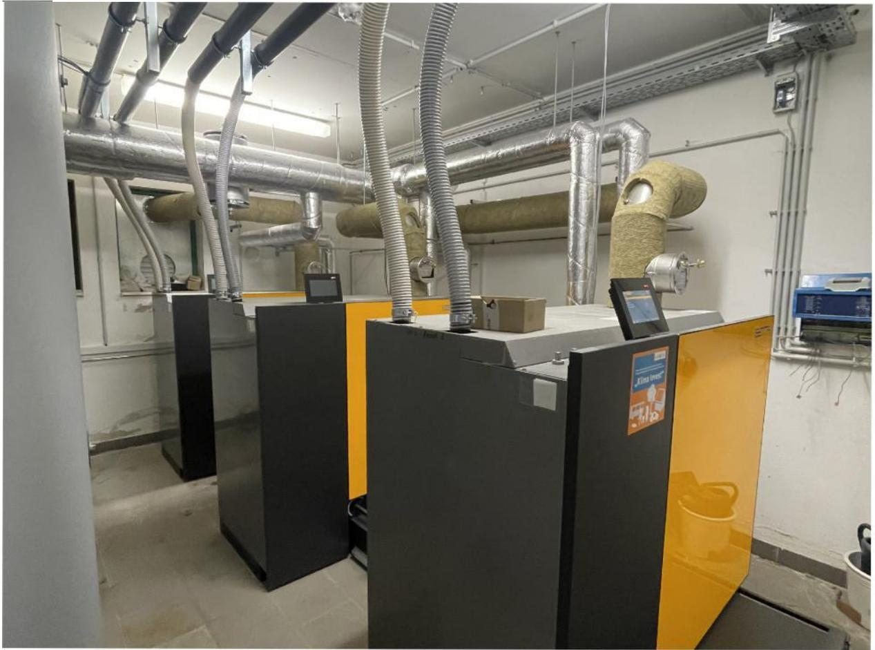
Heizungsanlage - Heizkessel (3x ETA PC 100 Baujahr 2023)
