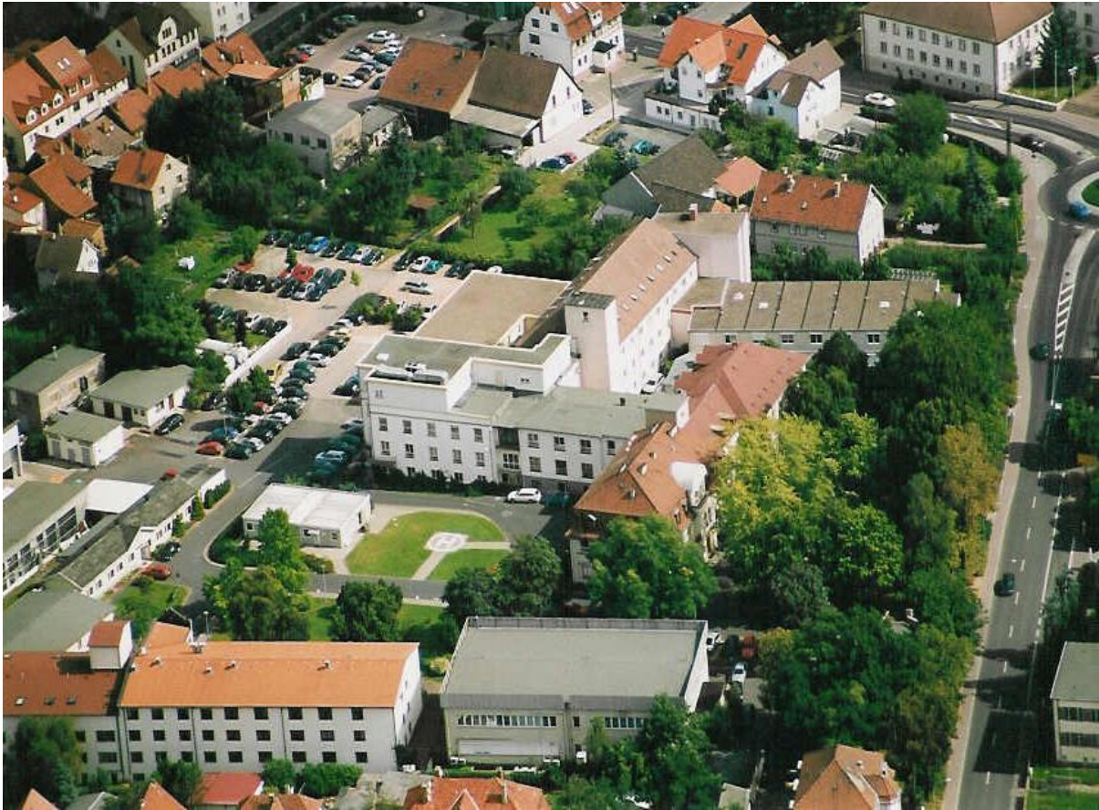
Standort altes Krankenhaus – Sitz der Fachschule
